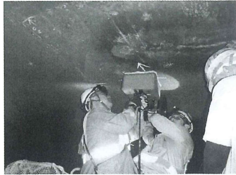
トンネル覆工天頂部での 現場データ採取状況
